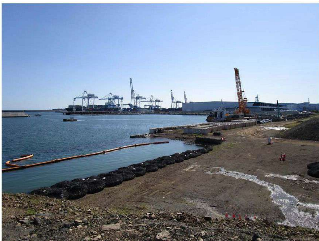
新興津物揚場 袋詰玉石製作据付工事 令和2年9月
