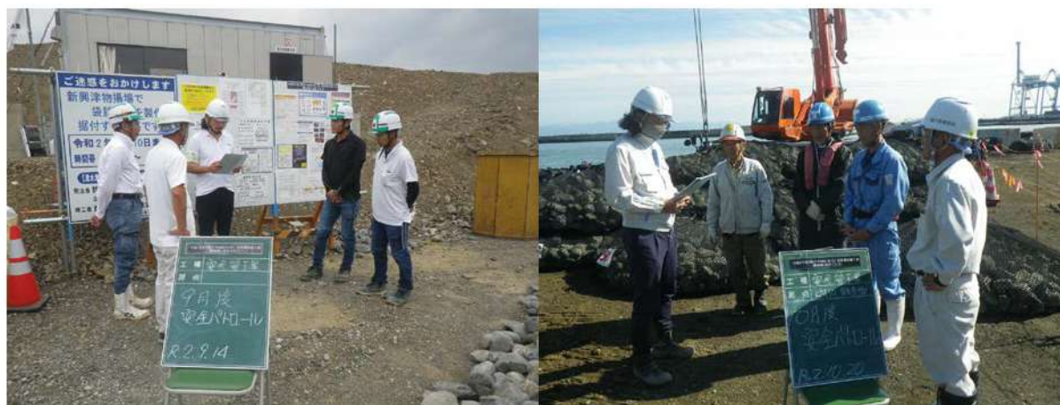
建設現場での安全訓練 令和2年9月、10月
